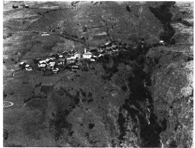
Abb. 3 Das am meisten gefährdete Dorf Peiden. Photo: Jules Geiger, Flims. (No. 6398 BRB 3. 10. 39)
