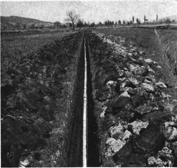
Abb. 7 Melioration der Rheinebene. Holzdrain fertig verlegt.
