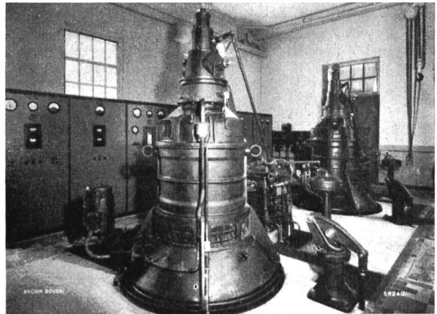
Abb. 7 Papierfabrik Serrières 2 Vertikalgeneratoren je 230 kVA, 750 U/min., direkt gekuppelt mit Kaplanturbinen (Charmilles).
