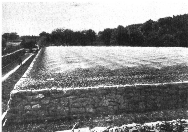
Abb. 9 Tropfkörper, alte Konstruktion mit Düsen. St. Gallen
