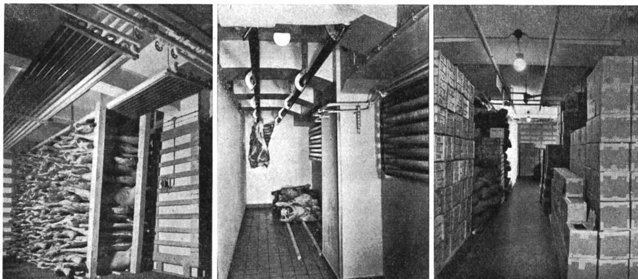
Luft besonders wichtig ist, wurde längs den Wänden ein Rost in Holzkonstruktion angebracht, der eine zwangsläufige Führung der Luftzirkulation bezweckt. Das im 3. Geschoss neben der Verladerampe befindliche Bureau ist durch eine Sonnerie- und Telefonanlage mit sämtlichen Räumen verbunden.
