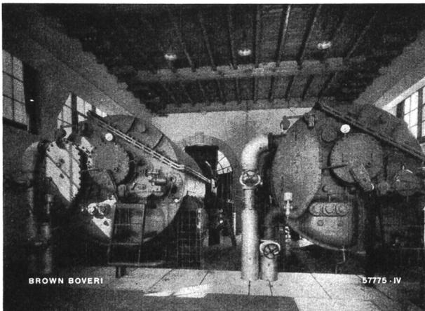
Fig. 10 Wärmepumpenanlage der Kunstseide A. G. Steckborn.
