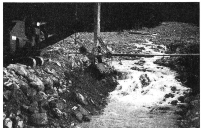
Abb. 12 Raupenlöfflbagger am Durnagelbach zur Ausgrabung eines 5 m tiefen Bettes als erste Sicherungsmassnahme.
