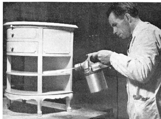
Fig. 8 Die Elektrospritzpistole im Gebrauch.
