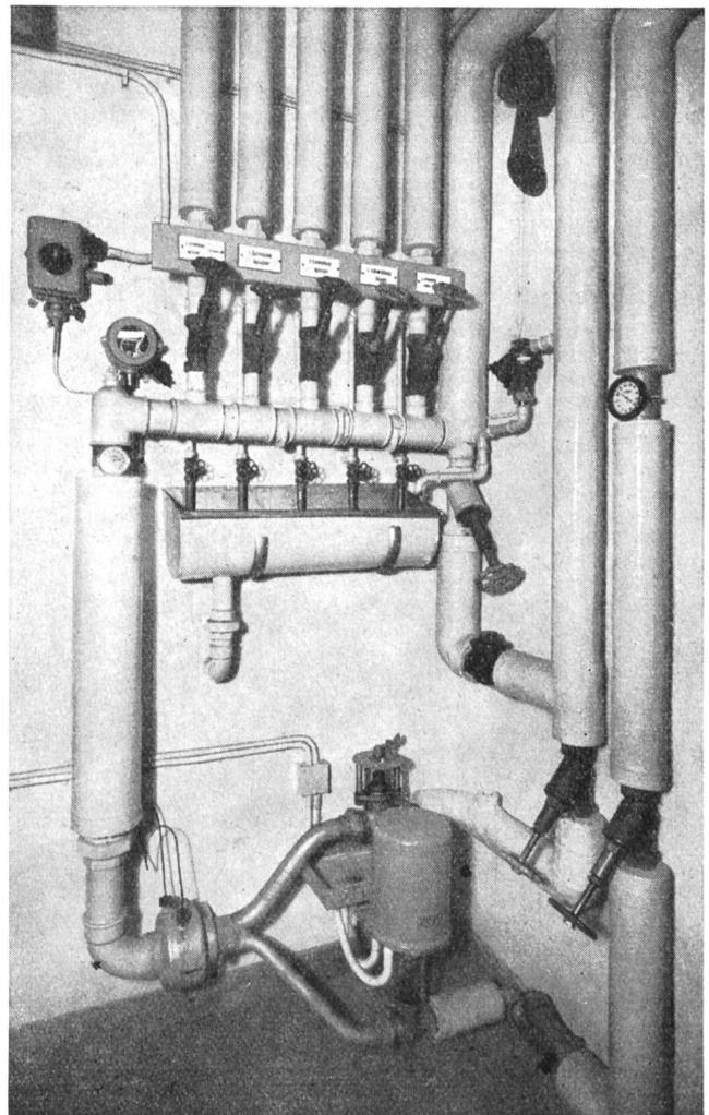
genaues Anpassen an die Abkühlungsverhältnisse automatisch konstant gehalten, und da jeder Witterungswechsel von den Apparaten sofort zur Steuerung ausgewertet wird, sind auch Ueberheizungen infolge unerwarteter Temperaturanstiege ausgeschlossen. Zudem kann nach bestimmtem Programm geheizt werden, so z. B. tagsüber voll und nachts stark reduziert. Die Einsparungen an Brennmaterial und an Bedienungsaufwand sind meist sehr bedeutend, und oft macht sich die Anlage in ein bis zwei Jahren bezahlt.
