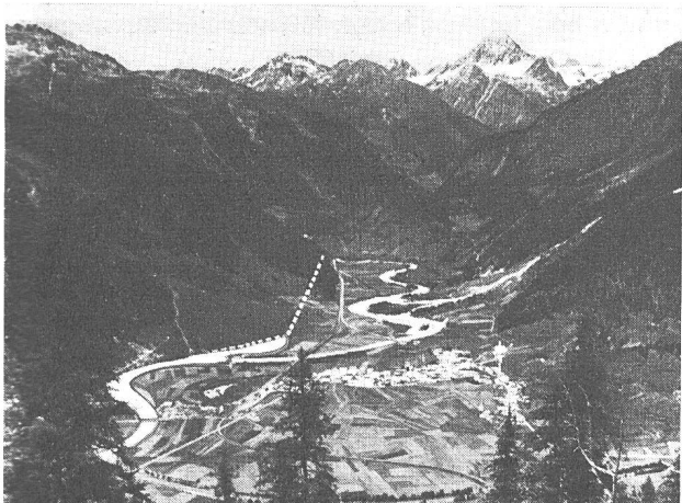
Abb. 1 Ansicht von Zernez, mit Blick gegen das Unterengadin. Links projektiertes Ausgleichbecken beim Bahnhof Zernez und linksseitiger Druckstollen, bis Clus sichtbar. (Siehe Abschnitt 3, Seite 38.)
