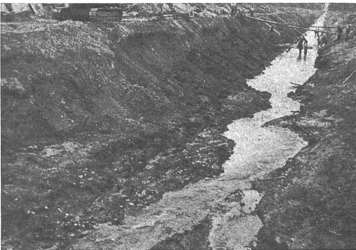
Abb. 17 Einbau der Sohlensicherung im Hauptkanal bei Müntschemier.
