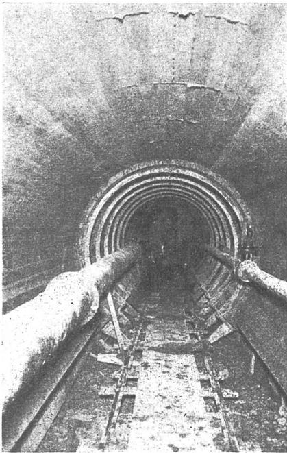
Abb. 19 Ausbetonierter Stollen mit eiserner Schalung.
