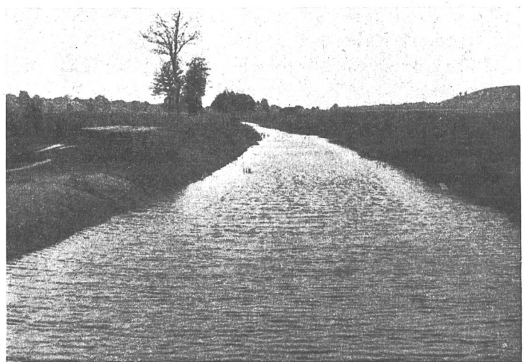
Abb. 27 Aufstau im Kanal Süd
