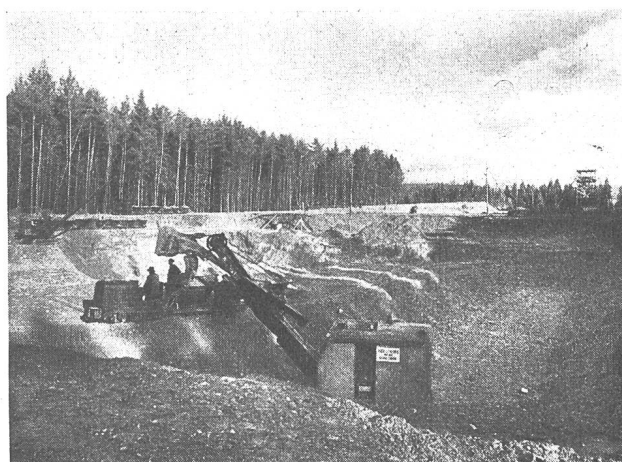
Abb. 9 Aushub der Maschinenhausbaugrube. Bauzustand vom 27. November 1946.
