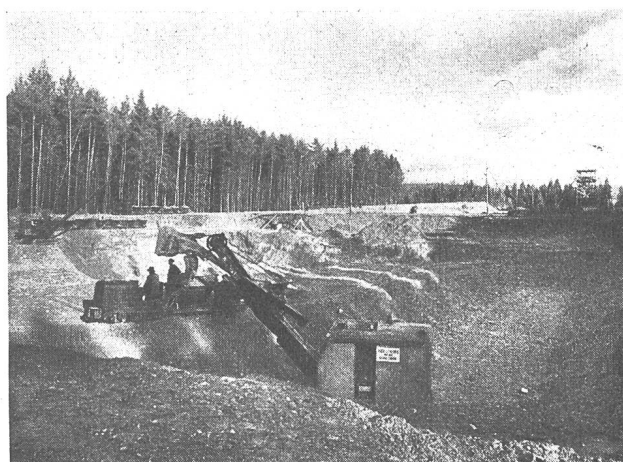
Abb. 9 Aushub der Maschinenhausbaugrube. Bauzustand vom 27. November 1946.
