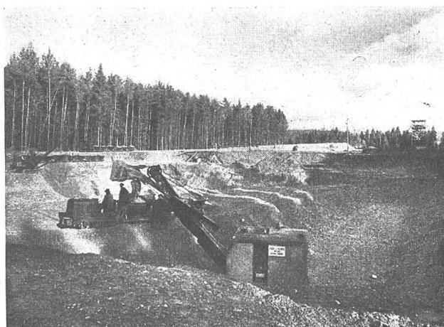
Abb. 9 Aushub der Maschinenhausbaugrube. Bauzustand vom 27. November 1946.
