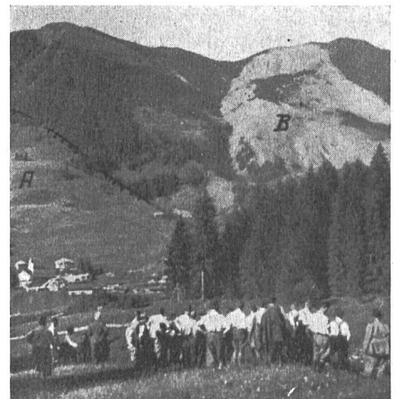
Abb. 10 Blick von Schönisei auf Sörenberg. A = postglazialer Rutsch, B = neuer Berggrutsch (siehe Abb. 9).
