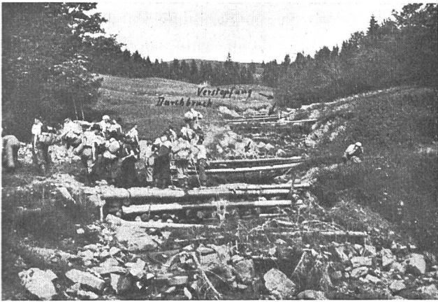
Abb. 12 Provisorische Verbauung des Wissibaches. Photo Ing. Rieser.
