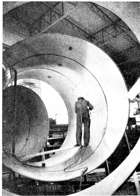
Fig. 19 Turbine Charmilles-Kaplan de 33 300 CV. Soudure à l'intérieur de la bêche spirale.
