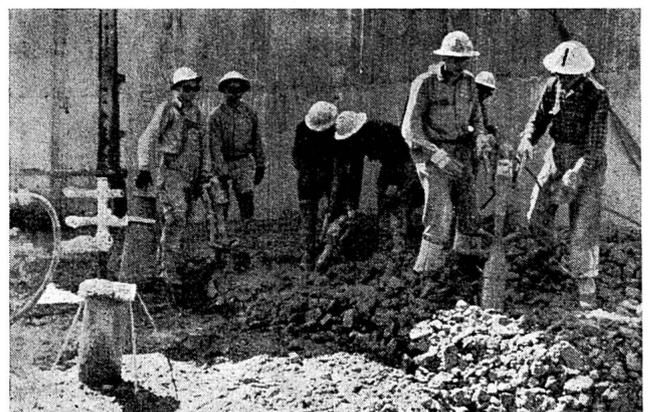
Abb. 5 Wolf Creek Dam. Vibrieren des Betons mit  $150 \text{ mm}$  Maximalkorn.
