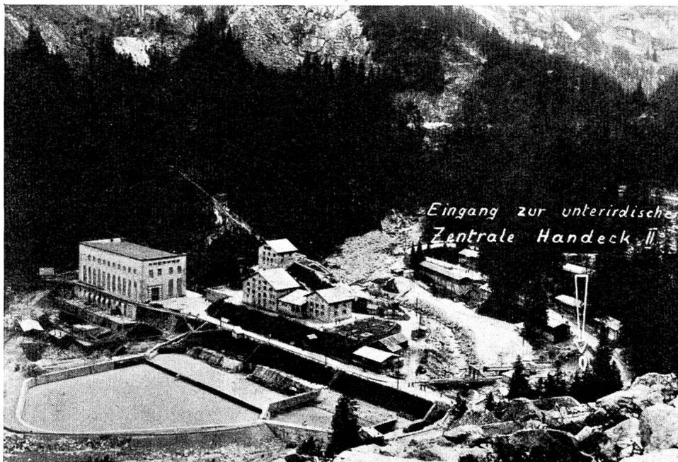
Abb. 1 Baustelle der Zentrale Handeck II. Links: Zentrale Handeck I und Maschinistenwohnhäuser; im Vordergrund links Ausgleichsweiher für den Wasserzufluss zum Kraftwerk Innertkirchen.
