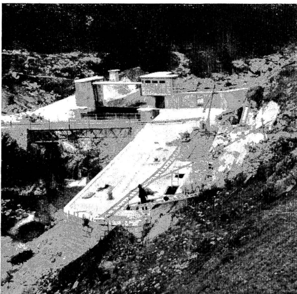
Abb. 13 Stauwehr und Entsander Meienreuss.
