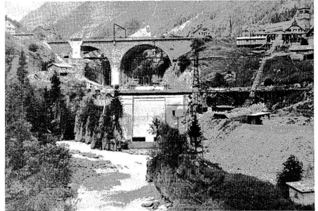
Abb. 8 Staumauer Göschenen, Ansicht vom Unterwasser aus.
