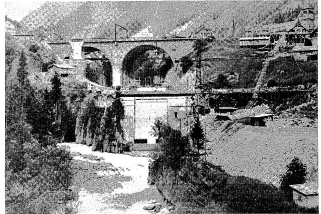
Abb. 8 Staumauer Göschenen, Ansicht vom Unterwasser aus.
