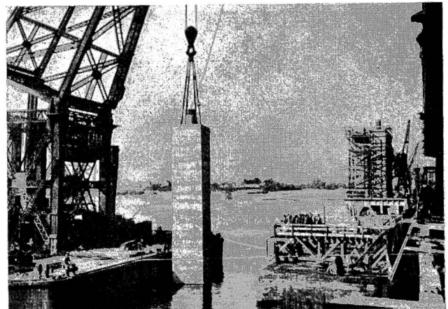
Abb. 5 Hafen von Nantes. Im Vordergrund Transport eines Caissons mit einem Schiffskran von 100 t Tragkraft. Im Hintergrund serienweises Herstellen der Eisenbetoncaissons.
