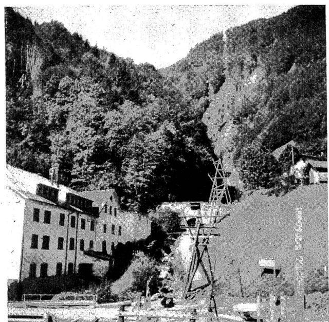
Abb. 9 Kraftwerk Luchsingen II. Provisorische Luftseilbahn und Hilfsluftseilbahn. Blick längs Schneise, schief gekreuzt durch Schneise der Druckleitung.
