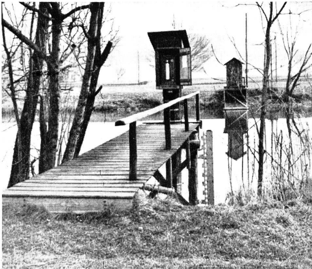
Abb. 5 Wassermessstation Zihlbrück. Ansicht vom Neuenburger Ufer aus. Im Vordergrund Limnigraphenstation, am andern Ufer Geschwindigkeits-Registrierstation.
