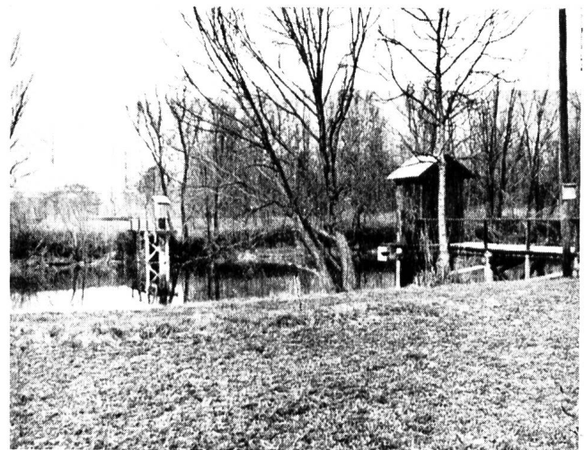
Abb. 6 Wassermessstation Zihlbrück. Ansicht vom Berner Ufer aus. Links Limnigraphenstation, rechts Geschwindigkeits-Registrierstation.
