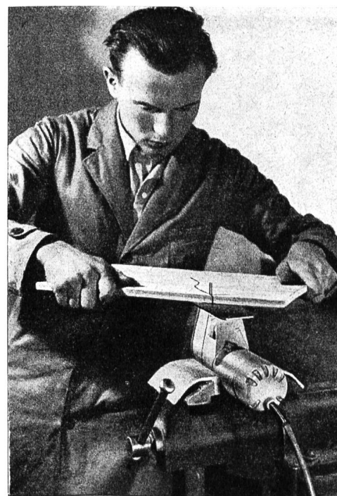
Abb. 19 Die ortsfeste Elektro-Handsäge (Scintilla)
