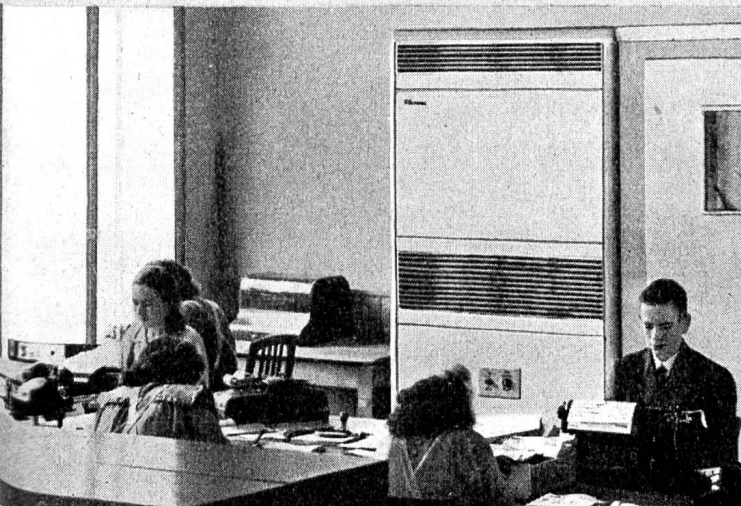
Klimagerät in einem Büro
