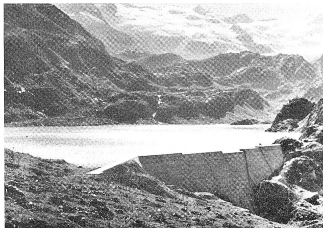
Stauanlage Mattenalp unterhalb des Gauligletschers im Urbachtal
