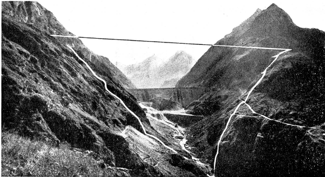
Abb. 27 Grande Dixence, zukünftige Staumauer und die im Jahre 1935 vollendete Mauer
