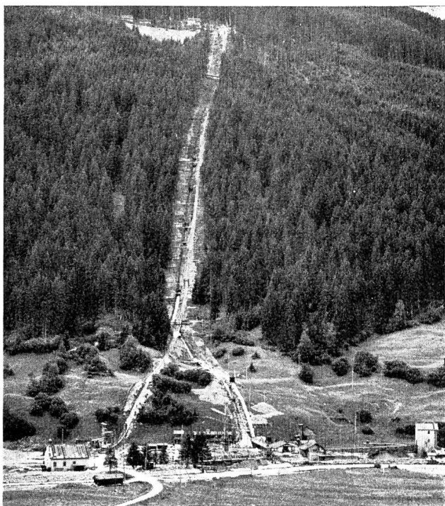
Abb. 17 Druckleitung, im Vordergrund Baustelle der Zentrale
