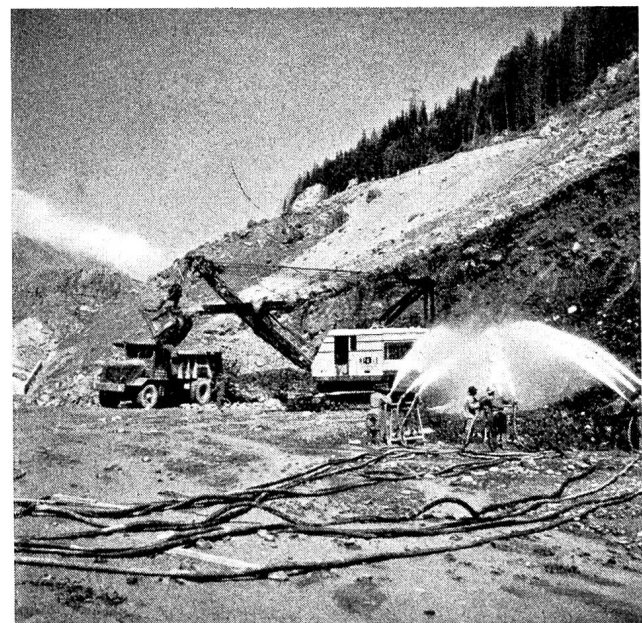
Abb. 25 Ausschwemmen des übermäßigen Feinkornanteils von Material (3) durch Bespritzen an der Gewinnungsstelle
