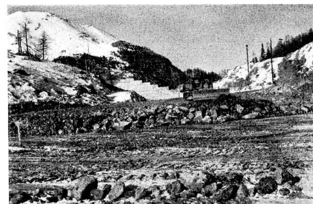
Abb. 26 Ausbreiten von Material (3) in Schichtstärke von 1 m mit schwerem Bulldozer
