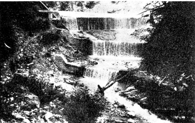
Abb. 5 Sperrensystem im Moränegebiet
