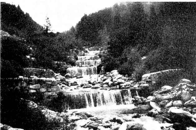
Abb. 6 Verbauung im Urgestein (Orlegna im obern Bergell)
