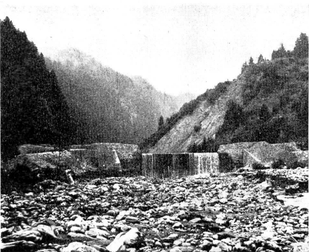
Abb. 8 Sperrenüberlauf mit seitlichen Flügeln
