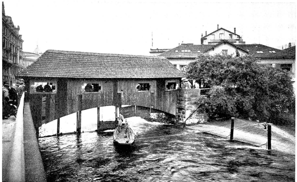
Abb. 6 Einsetzen der Winterstauwände beim zedeckten Brüggl und Globus
