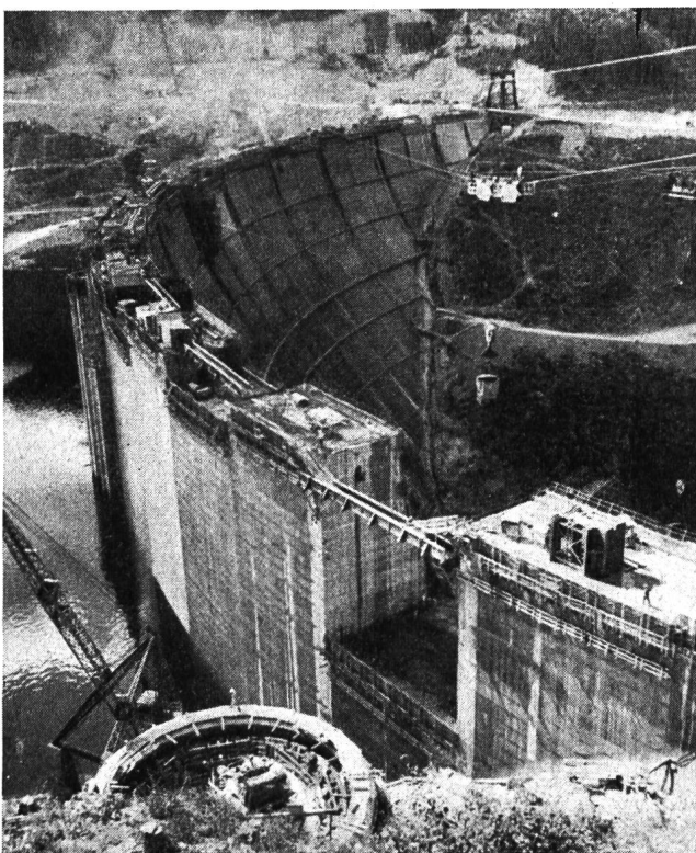
Abb. 4 Hungry-Horse Dam, Bogenstaumauer im Bau
