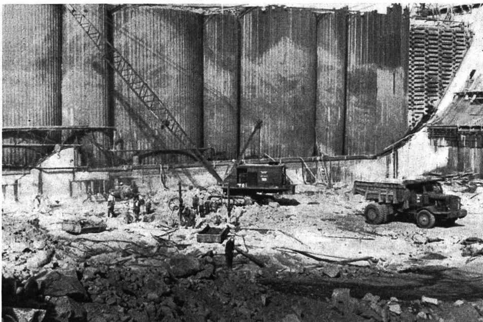
Abb. 10 Chief Joseph Dam, Zellenfangdämme aus eisernen Spundbohlen als Baugrubenabschlüsse
