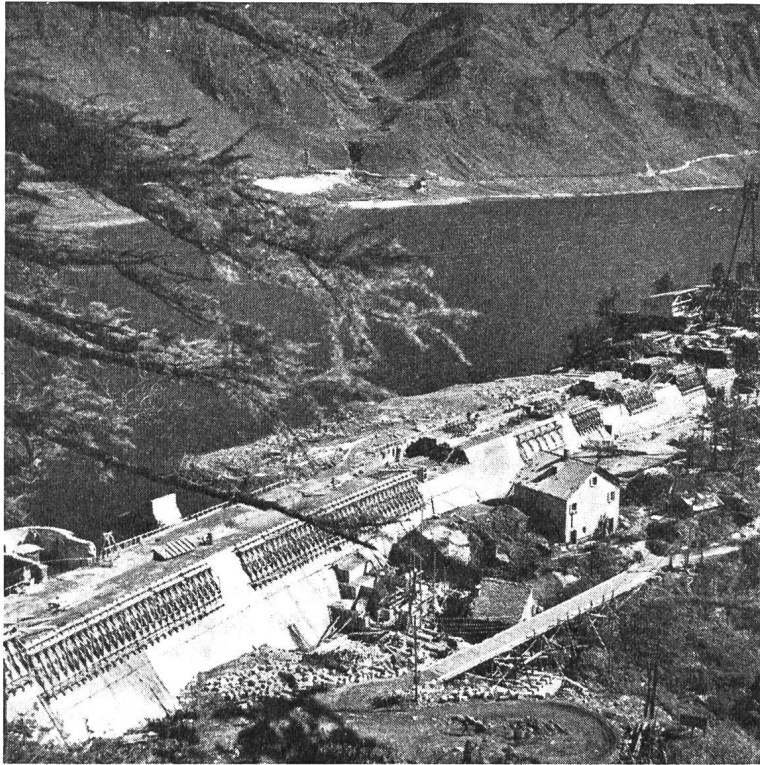
Abb. 12 Neue Staumauer Piora, Bau- zustand Ende August 1952. Am gegenüberliegenden See- ufer, rechts von der weißen Deponiefläche, die Ausmün- dung des Garegnastollens
