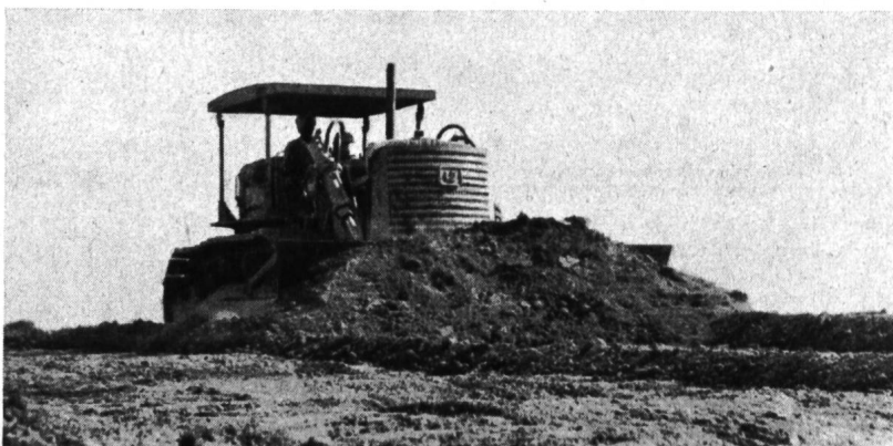
Abb. 4 D7 Raupenschlepper mit Angledozer beim Planieren am Sennar-Damm
