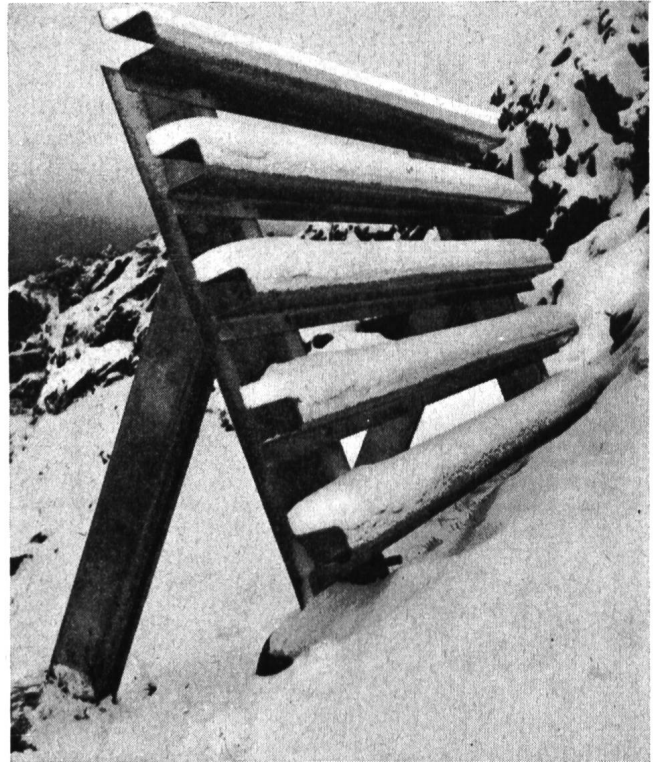
Abb. 2 Lawenverbauung im Anbruchgebiet; Schneebücke aus Leichtmetall
