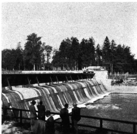
Abb. 3 Überflutbares Saalach-Kraftwerk Rott-Freilassing der Städtischen Elektrizitätswerke Salzburg. Links Ansicht des unterwasserseitigen Wehrkörpers mit Klappschützen, rechts das Wehr bei Überflutung
