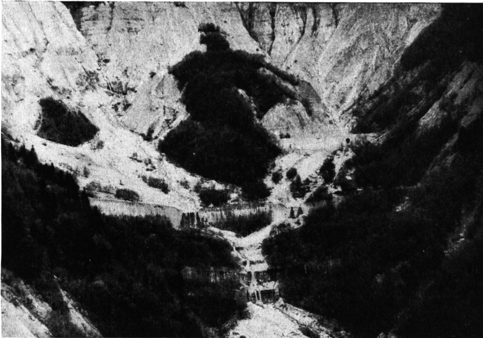
Abb. 1 Schesha-Oberlauf. Blick in den Bruchkessel mit oberer Sperrenstaffel; im Hintergrund rechts Sperre 107 in km 1.50 (Hölltobel), davor die 21 m hohe, 197 m lange Sperre 88 in km 42.68, bei der die Sohle schon um 70 m gehoben ist.
