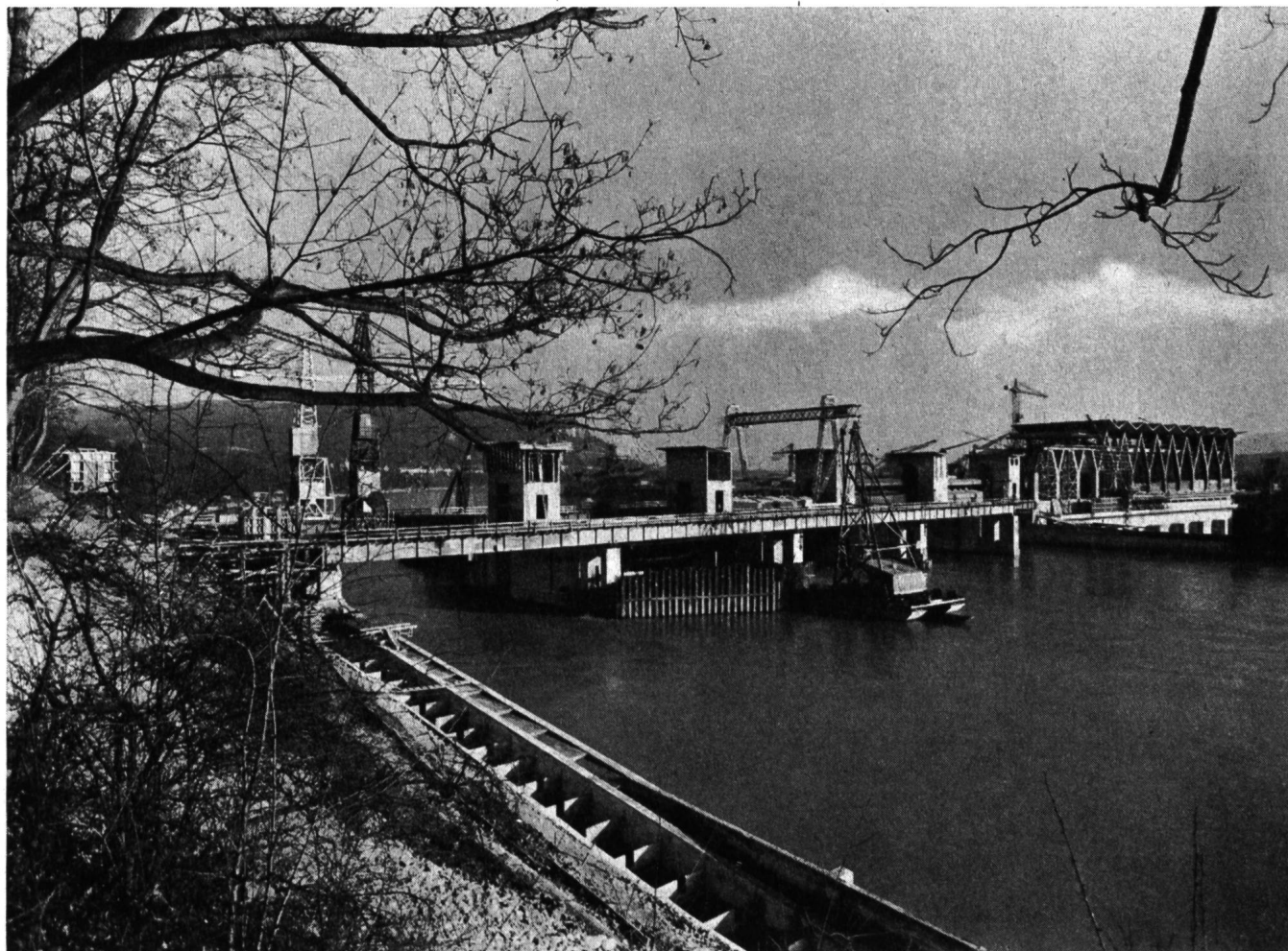
Abb. 8 Blick vom rechten Rheinufer auf die Unterwasserseite von Stauwehr und Maschinenhaus; im Vordergrund der Fischpaß. Bauzustand Januar 1954.
