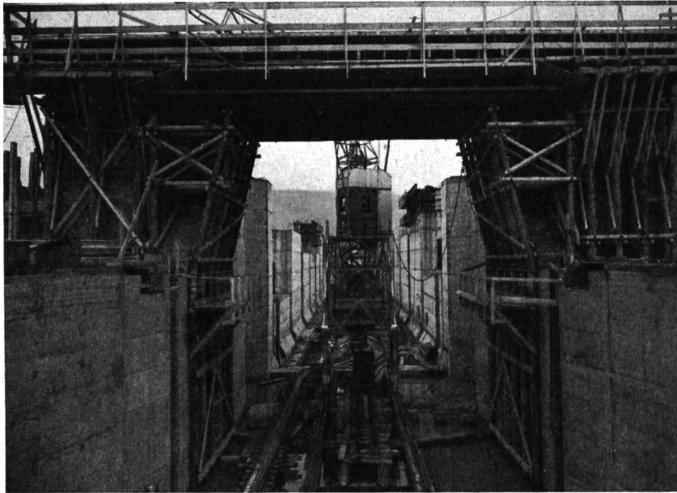
Abb. 13 Schleusenbrücke eingerüstet, Brücke betoniert. Durchblick gegen Oberhaupt; rechts O. K. Schleusenmauer 255.60 bei Block 2 erreicht.
