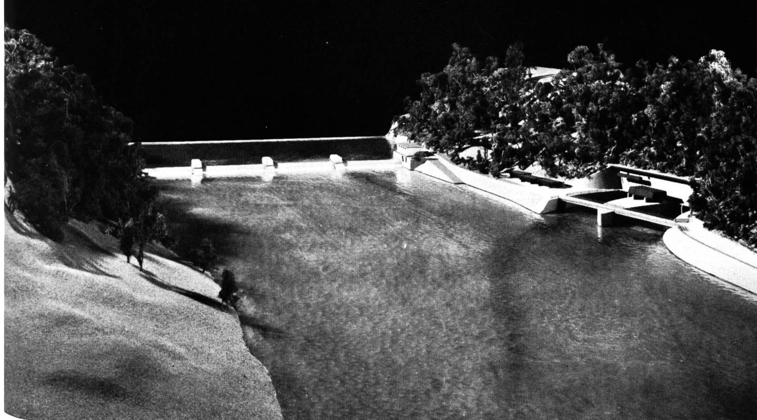
Abb. 15 Unteres Hilfswehr mit Reguliergebäude und Kahnrampe am linken Ufer, Stollenausläufe. Modellaufnahme vom Unterwasser
