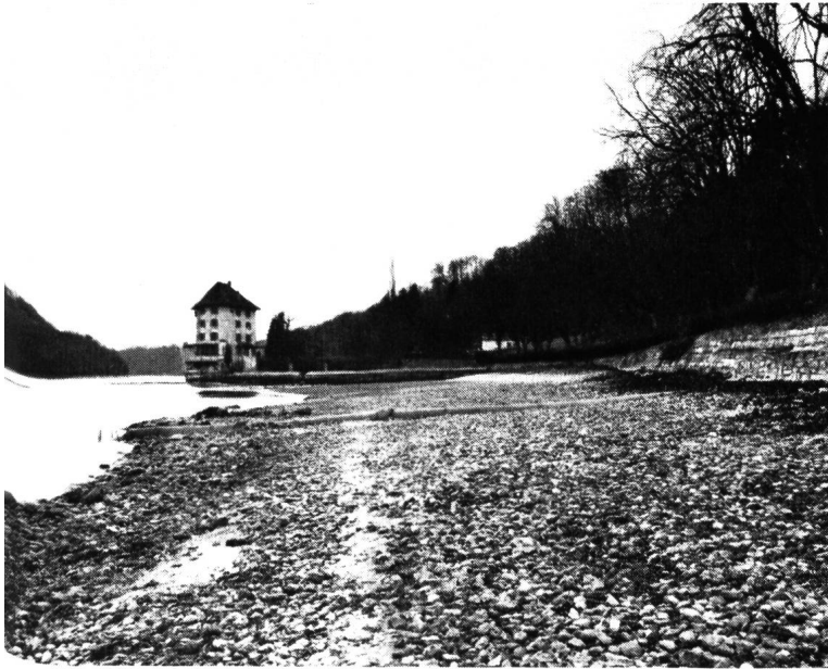
Abb. 21 und 22 Schlößchen Wörth mit Uferpartie des Rheinfallbeckens, links bei Niederwasser (160 m 3 /s), rechts bei Mittelwasser (560 m 3 /s). Der heute im Winter zutage tretende schmutzige Kiesstrand mit häßlichen Kanalisationsröhren würde in Zukunft stets vom Wasser überdeckt; die vorgesehenen maximalen Wasserstände (Koten 358,50 bis max. 359,00 m ü. M.) liegen 10 cm unter bzw. 40 cm über dem in Abbildung rechts ersichtlichen Wasserspiegel.
