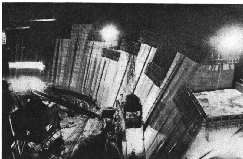
Abb. 3 Die Baustelle «Vieux Emosson» bei Nacht
