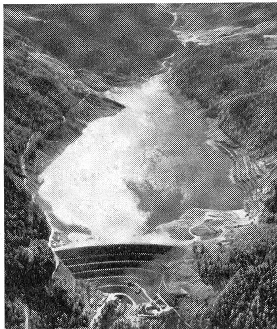
Staudamm Castiletto, Marmorera (in Arbeitsgemeinschaft)
