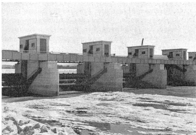
Abb. 4 Kraftwerk Donzère-Mondragon, Stauwehr bei Donzère
