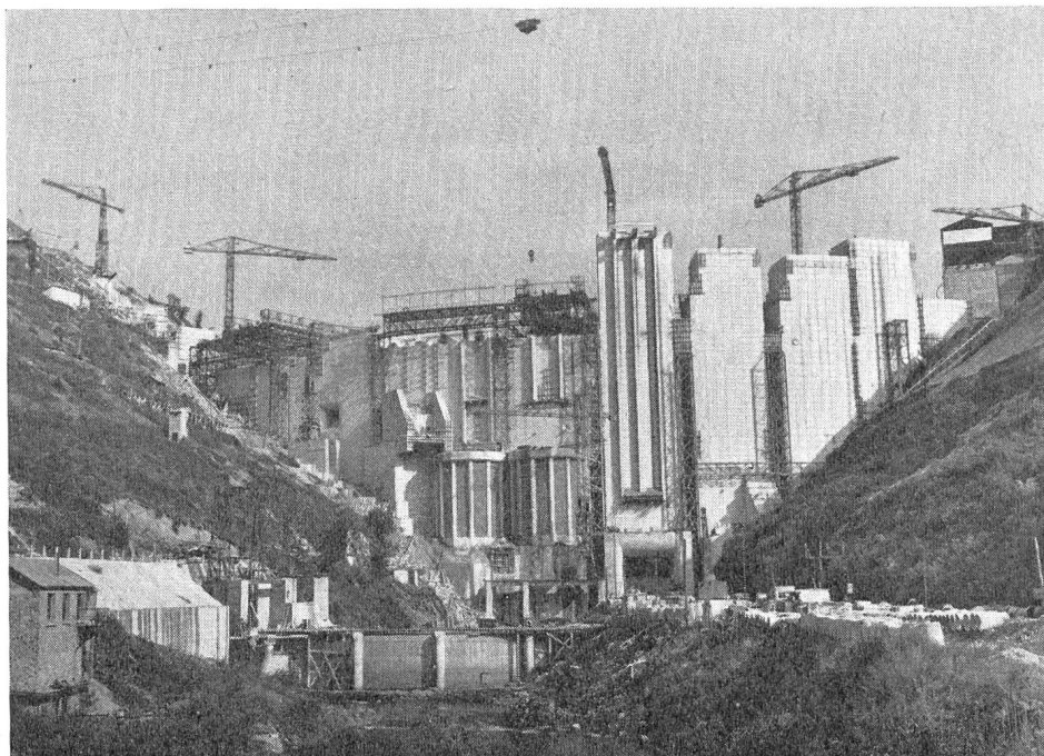
Fig. 13 Barrage de Bort-les-Orgues; vue d'amont, prise pendant la construction, montrant les grilles des prises d'eau et l'entrée des vidanges
