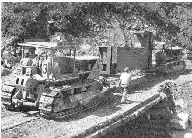
Abb. 3 Staumauer Zervreila. Schwieriger Transport eines Kabelkranteiles vom Talboden zur hochgelegenen Kranfahrbahn
