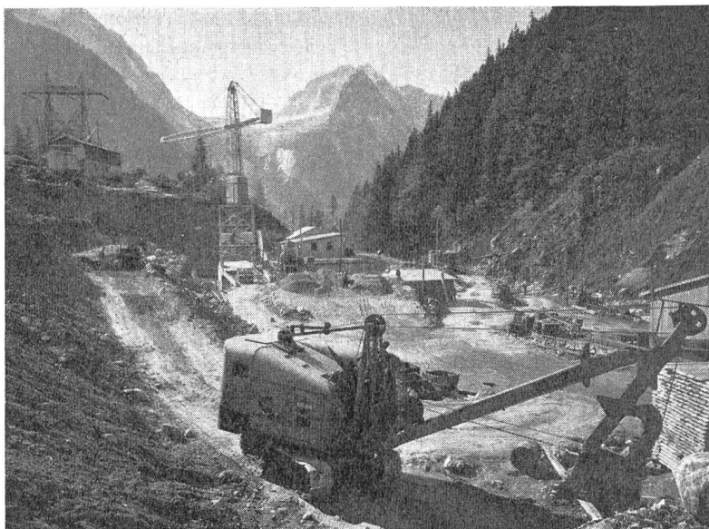
Abb. 8 Baustelle Löbba (Stauwehr und Zentrale); im Hintergrund Albigna (Photo Beyeler, Zürich)
