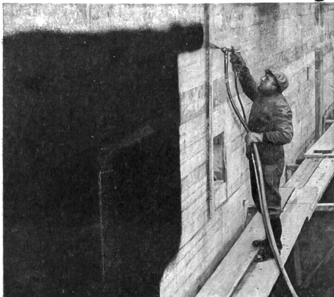
Fundamentabdichtung am neuen Verwaltungsgebäude des Elektrizitätswerkes Winterthur
