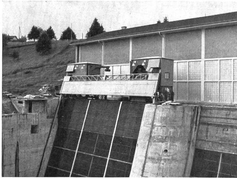
Rechenreinigungsmaschinen mit Dammbalkenversetz-Vorrichtung im Kraftwerk Rheinau
