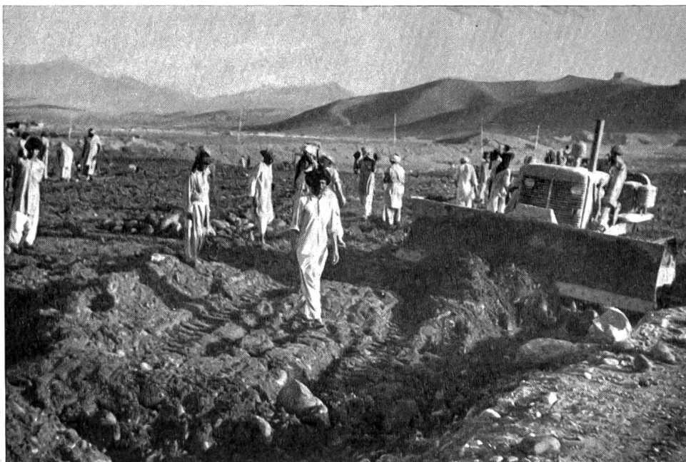
Abb. 15 Baran-Damm. Ausbreiten des Materials und Herauslesen der Steine von Hand (Photo A. Wackernagel)
