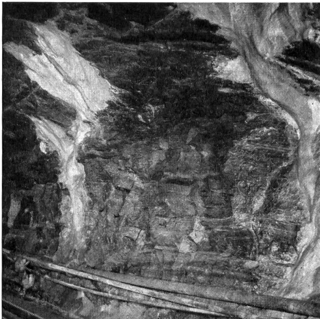
Kraftwerk Zervreila, Abdichtung des Zulaufstollens mit Barra Rapid
