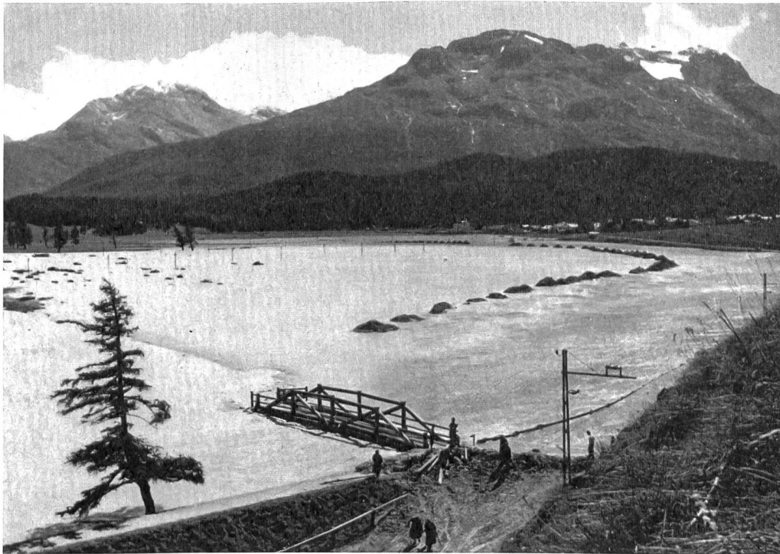
Abb. 1 Hochwasser vom 2./3. September 1956 zwischen Schlarigna/Celerina und Samedan. Der Flaz ist wiederum durchgebrochen, er hat die Weiden und das Innbett überflutet und darin viel Sand und Schlamm abgelagert; auch die Kantonsstraße ist unter Wasser. Im Wasser sind die nach den letzten Hochwassern aus dem Inn gebaggerten Sandhaufen sichtbar.
