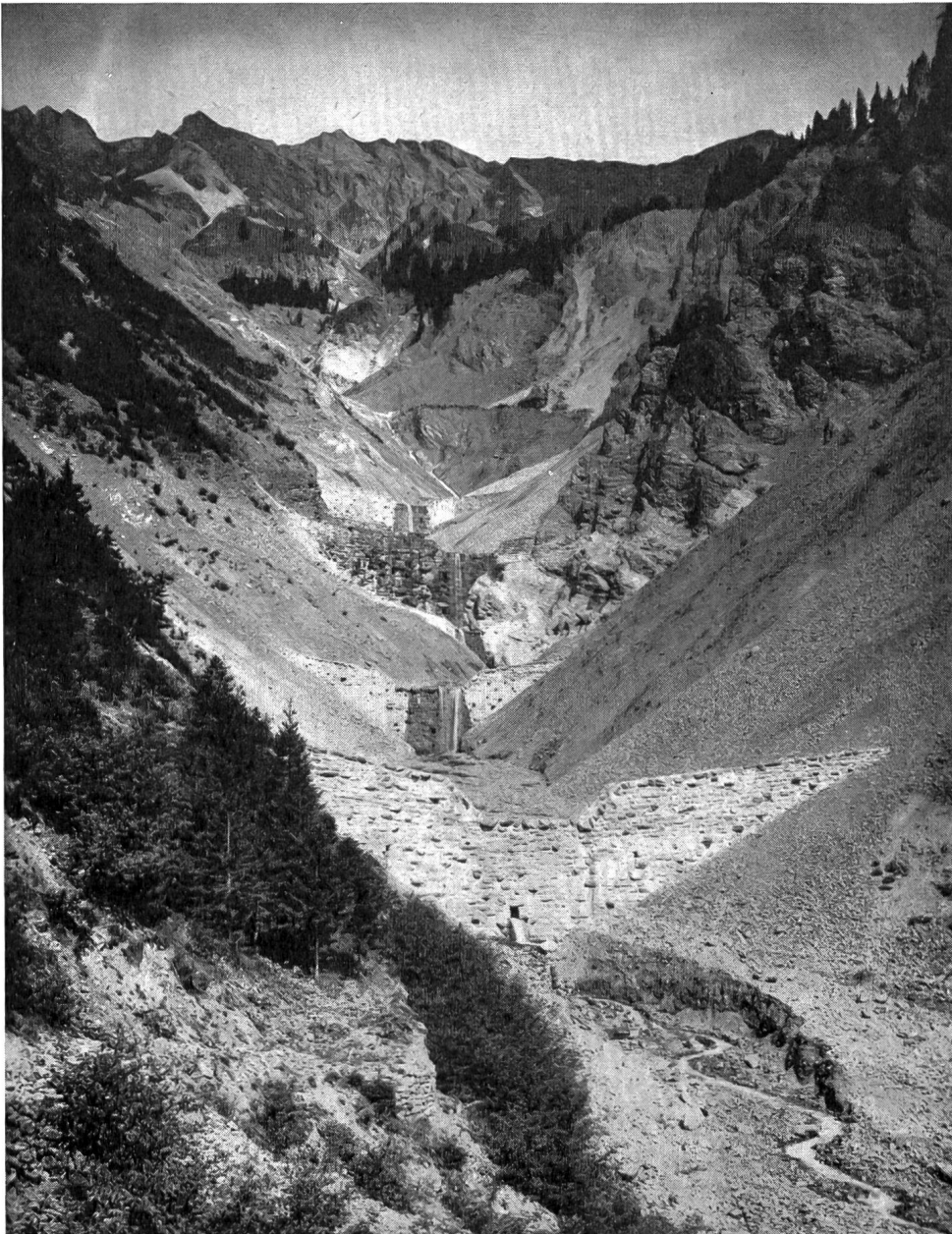
Abb. 3 Verbauungen im Lambach, aufgenommen im August 1913
