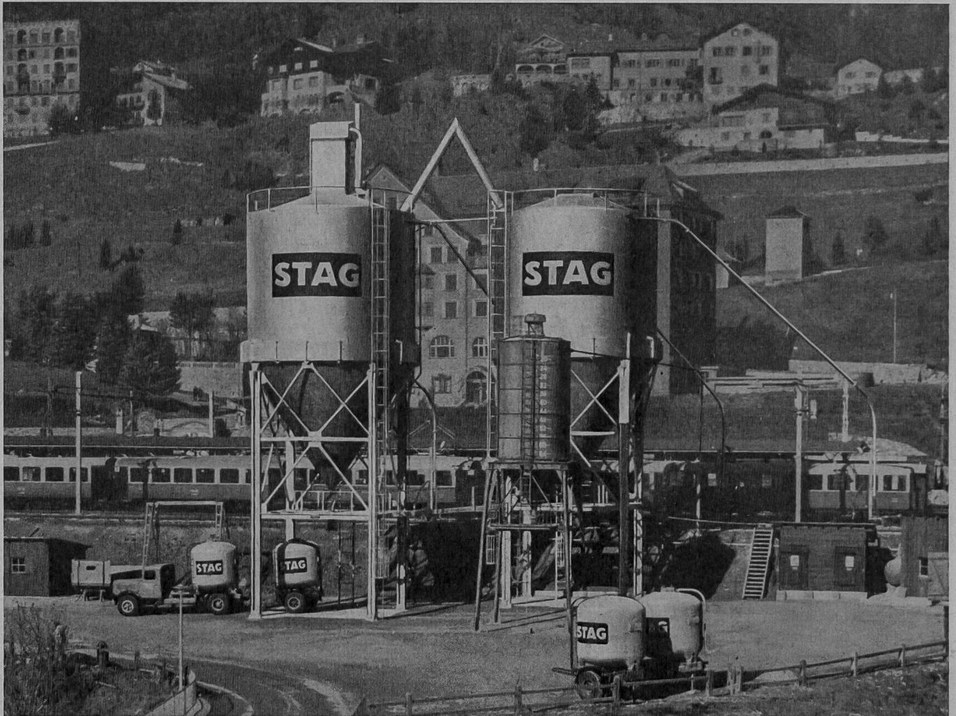
Umschlagsanlage der STAG in St. Moritz: 2 Silos à ca. 600 t Fassungsvermögen, 1 Silo à ca. 60 t Fassungsvermögen
