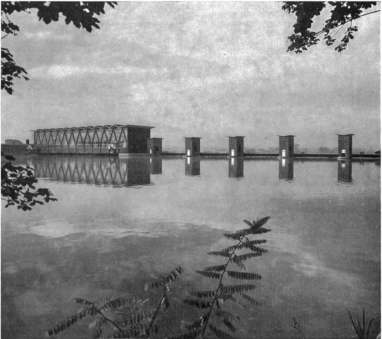
Abb. 2 Kraftwerk Birsfelden am Rhein; Maschinenhaus und Stauwehr von der Oberwasserseite gesehen (Photo KW Birsfelden)
